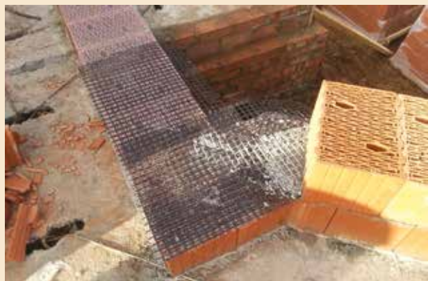
Армирование кладки из СуперТермо38
