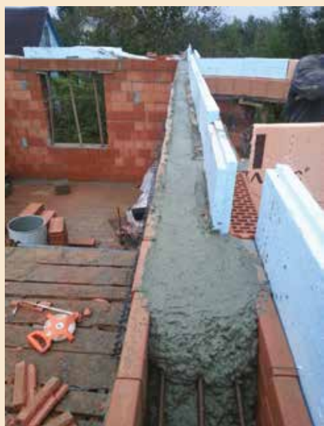
Керамические перемычки над оконными проемами
