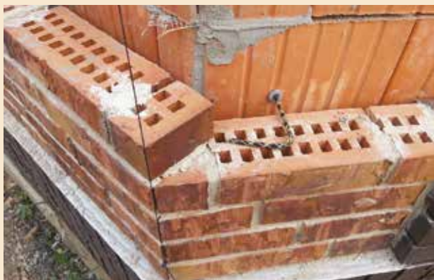
Армирование кладки с помощью химанкеров
