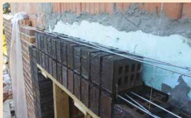
Формирование керамической перемычки с помощью арматуры БАУТ
